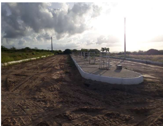
FOTO 24: AV. PROJETADA 1 – TERRAPLENAGEM, MEIO FIO, POSTES ELÉTRICOS E ARBORIZAÇÃO.
