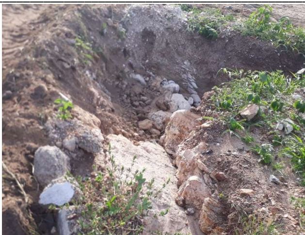
FOTO 22: RUA PROJETADA R-6 – ROCHA NO LOCAL DO POSTE ELÉTRICO.
