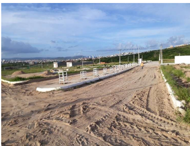
FOTO 23: AV. PROJETADA 1 – TERRAPLENAGEM, MEIO FIO, POSTES ELÉTRICOS E ARBORIZAÇÃO.
