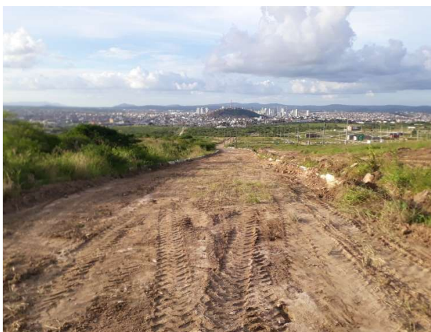
FOTO 01: RUA PROJETADA R-1 (AO LADO DA QUADRA C, TERRAPLENAGEM E EXECUÇÃO DO MEIO-FIO).
