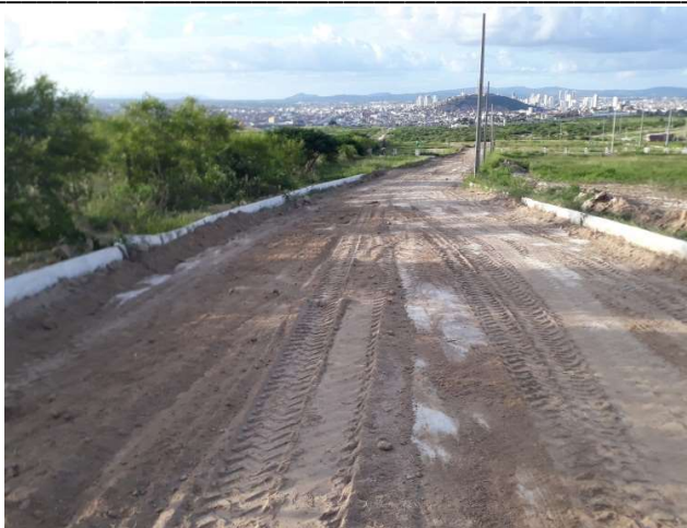
FOTO 04: RUA PROJETADA R-1 (AO LADO DA QUADRA D, EXECUÇÃO DE MEIO-FIO E POSTES ELÉTRICOS).
