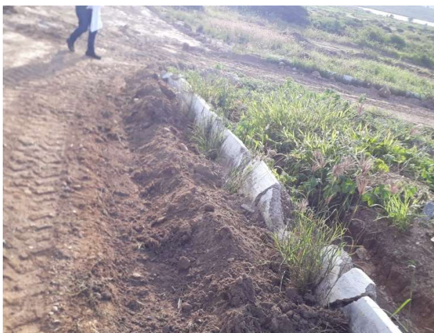
FOTO 21: RUA PROJETADA R-6 – TERRAPLENAGEM E MEIO FIO.
