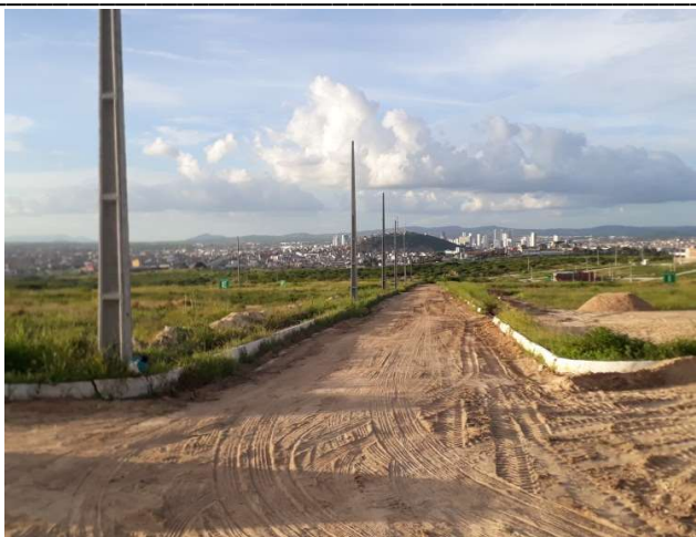
FOTO 10: RUA PROJETADA R-2 (ENTRE AS QUADRAS E e I ), TERRAPLENAGEM, MEIO-FIO E POSTES ELÉTRICOS.
