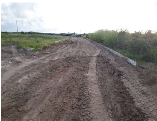
FOTO 14: RUA PROJETADA R-3 , TERRAPLENAGEM E MEIO FIO.
