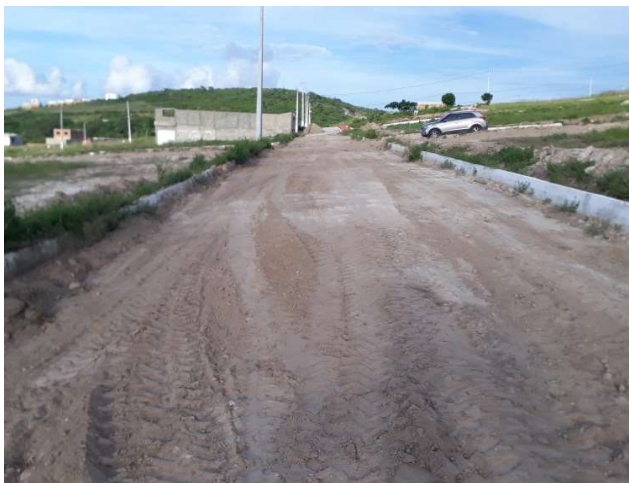
FOTO 17: RUA PROJETADA R-5 – TERRAPLENAGEM, MEIO-FIO E POSTES ELÉTRICOS.
