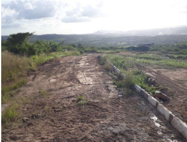
FOTO 19: RUA PROJETADA R-6 (ATRÁS DAS QUADRAS C e G )TERRAPLENAGEM E MEIO FIO.
