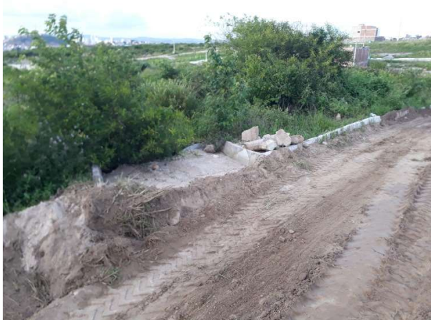
FOTO 13: RUA PROJETADA R-3 – PONTO DE ESCOAMENTO SUPERFICIAL PARA ÁGUA PLUVIAL.
