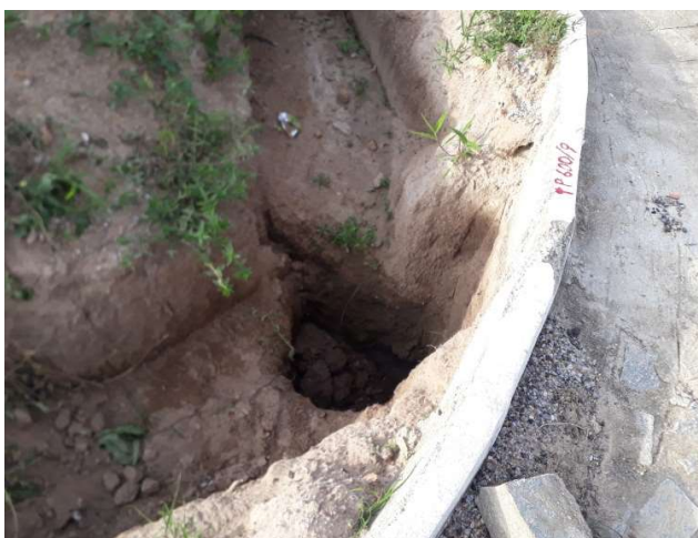
FOTO 20: RUA PROJETADA R-6 , LOCAÇÃO DE POSTE ELÉTRICO SITUADO NA QUADRA C.
