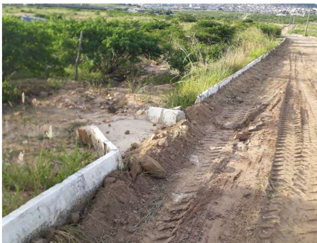
FOTO 03: RUA PROJETADA R-1 (AO LADO DA QUADRA C, EXECUÇÃO DA DRENAGEM SUPERFICIAL DE ÁGUA PLUVIAL).
