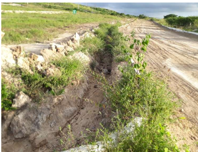
FOTO 18: RUA PROJETADA R-5, MEIO-FIO E ESCAVAÇÃO PARA REDE DE ESGOTO SANITÁRIO.
