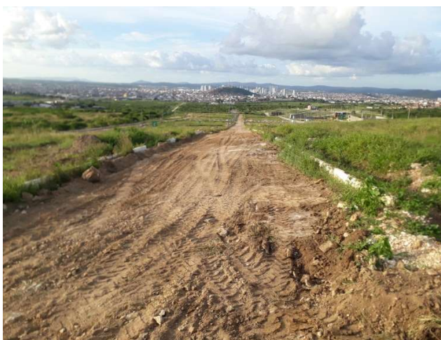
FOTO 08: RUA PROJETADA R-2, (ENTRE AS QUADRAS C e G), TERRAPLENAGEM E MEIO-FIO.
