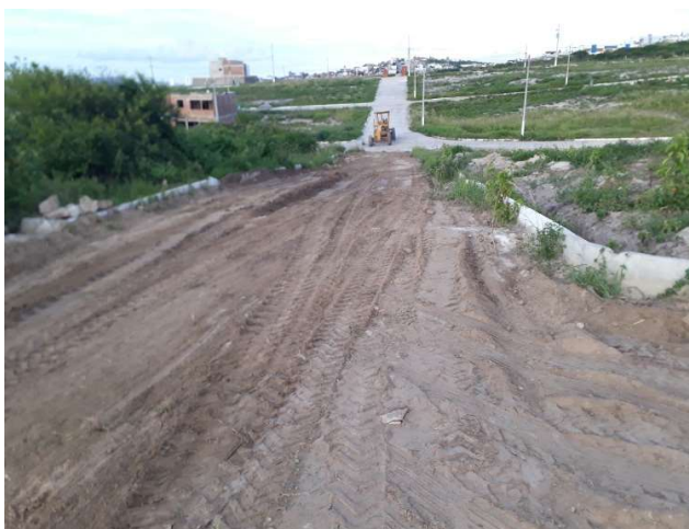
FOTO 12: RUA PROJETADA R-3 (DIVISA COM A PRIMEIRA ETAPA DO MORADA VERDE 1 ) – TERRAPLENAGEM E MEIO-FIO.
